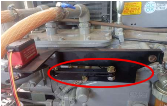
Gambar 3.1 — Pemasangan servo gas dan setelah (servo + dudukan + tuas custom sudah terpasang rapi).
